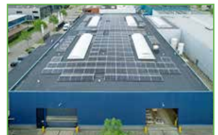
Boxtel (NL) Start: 11.2022 Max. Leistung: 175 MWh
